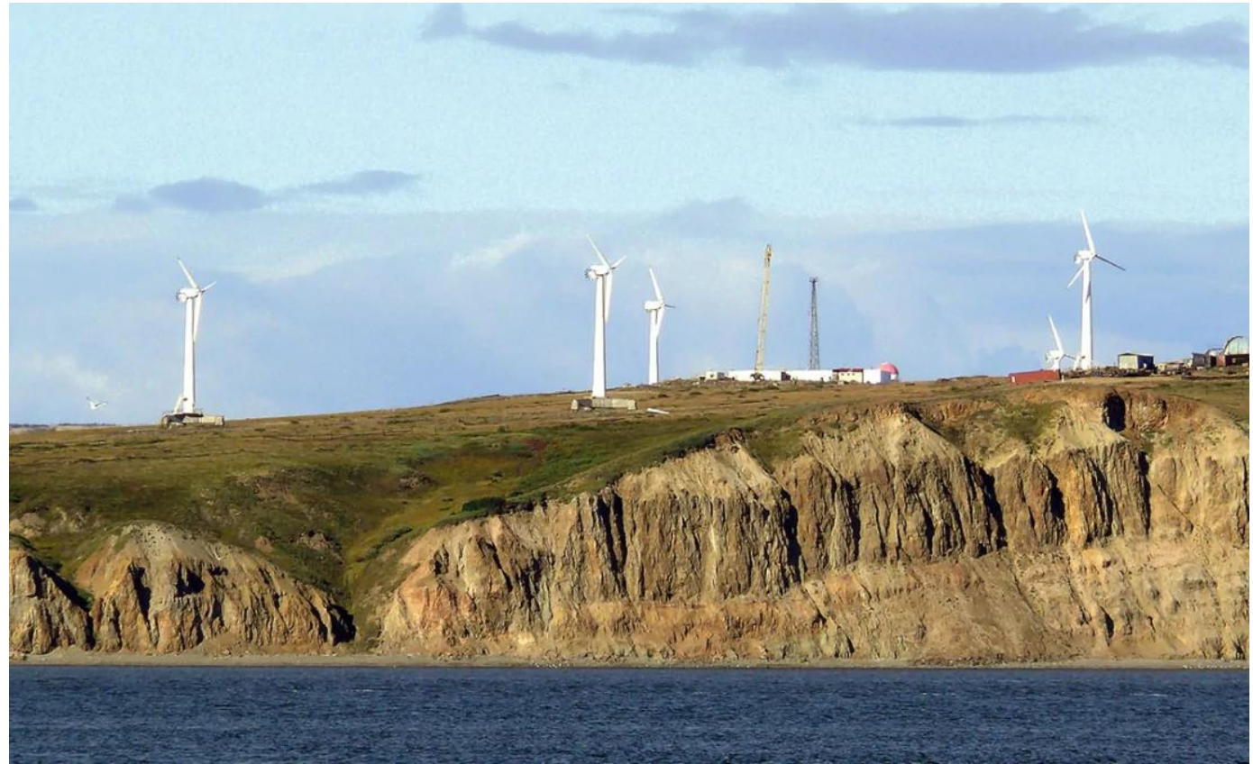
Анадырская ВЭС на мысе Обсервация, Чукотский АО
