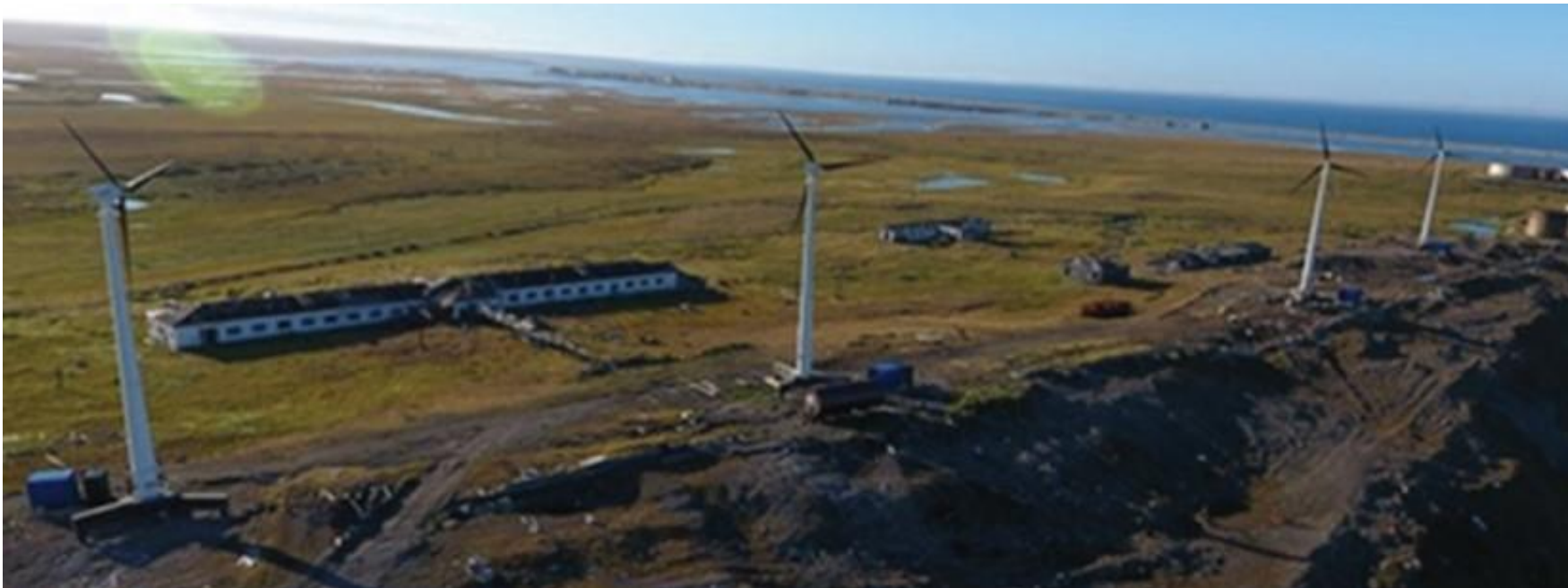
ВДЭС около посёлка Амдерма. ВЭУ Ghrpower-50 (мощностью 50 кВт, в арктической версии)
