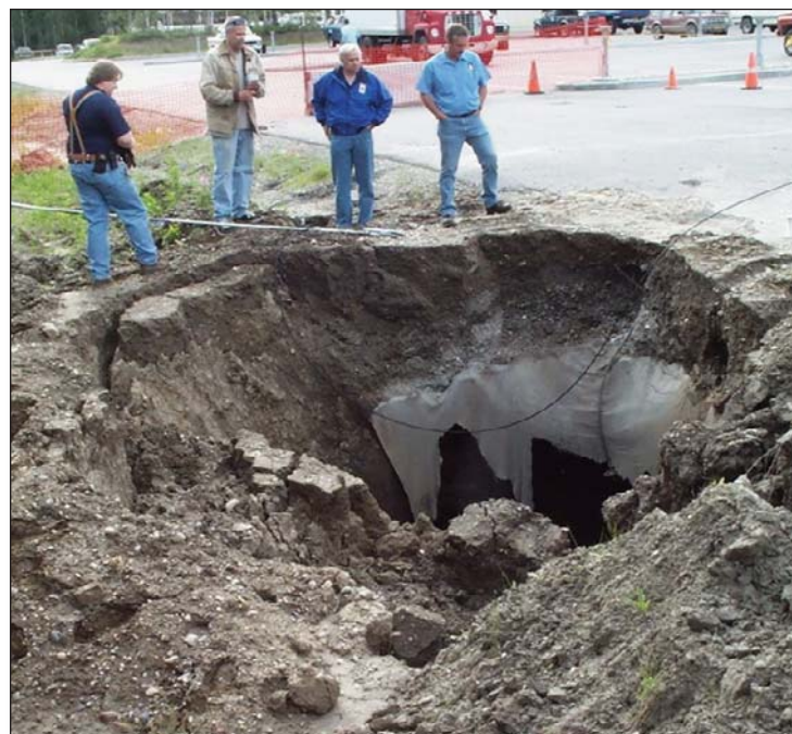
Рис. 8. Провал, образовавшийся при строительстве и эксплуатации автостоянки в результате протаивания подземных льдов близ Геофизического института Университета Аляски в Фэрбенксе. Фото В. Романовского
