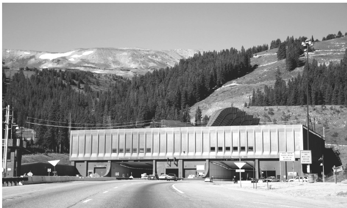
Рис. 37. Восточный портал тоннеля Эйзенхауэра–Джонсона (1973–1979 гг.) в Скалистых горах (США). Фото Н. Г. Украинцевой
