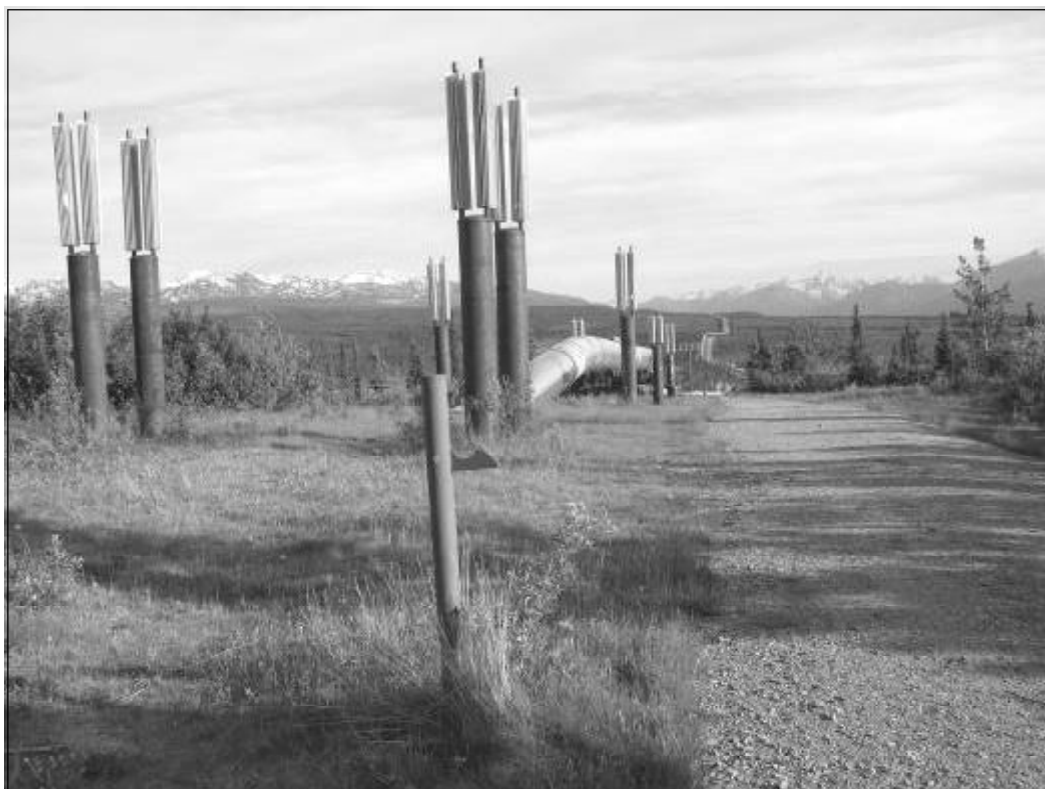
Рис. 32. Термосваи ( heat-pipes ), препятствующие растеплению грунтов на Аляскинском нефтепроводе. Фото Н. Г. Украинцевой
