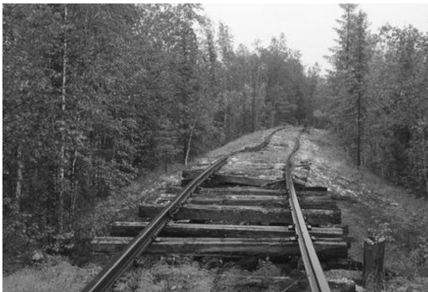
Рис. 30. «Мертвая» дорога Чум–Салехард–Игарка в наши дни (см. рис. 14). Деформация верхнего строения пути за счет экзогенных процессов
